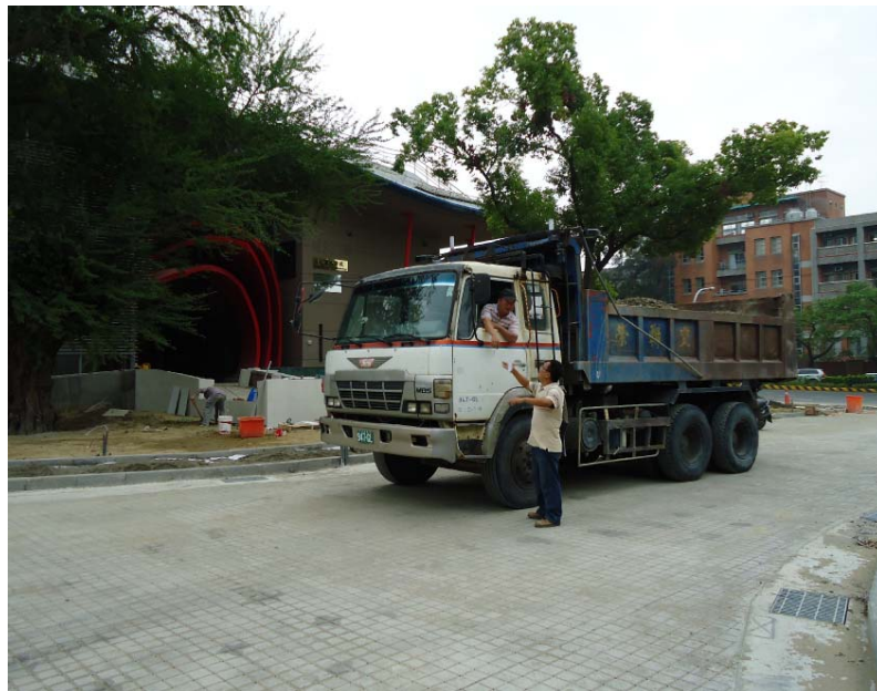
圖 7：台南成功大學「孫運璿綠建築科技大樓」前的 JW 鋪面道路。
