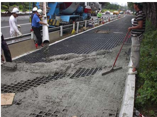
(b) 第二步：倒水泥混凝土
