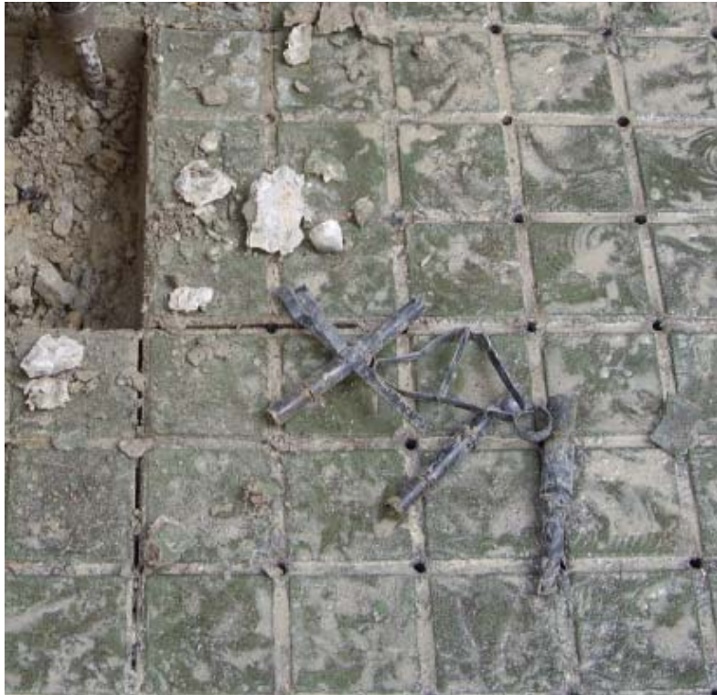
(b) 挖出的導水管(在室內拍攝)
