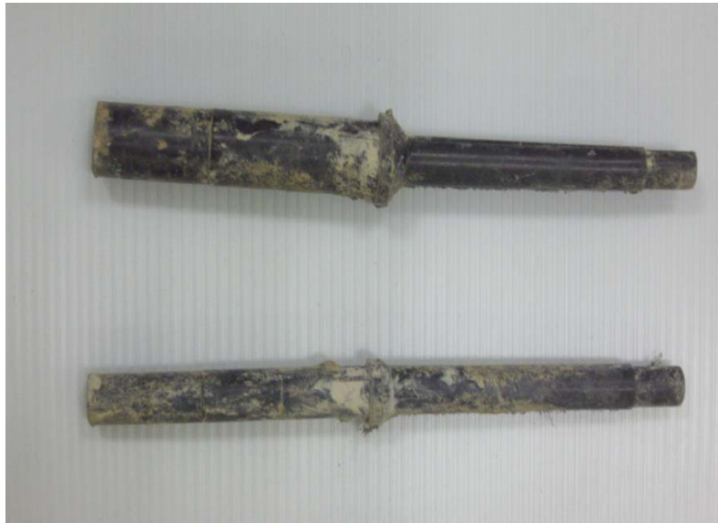
圖 5：八年後挖出的導水管。
