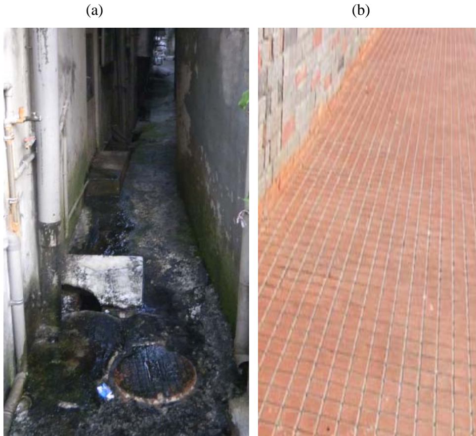
圖2：(a)骯髒的後巷，注意左側的排水溝是老鼠、蟑螂、蚊蟲的溫床。(b) 使用「高承載高透水鋪面」，將後巷的排水溝完全遮蔽，也將防止髒亂與傳染疾病。
